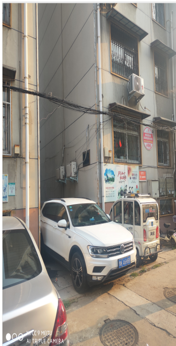
部分老旧小区现状照片
