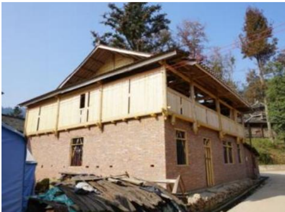
图 1.3- 42 下砖上木围护墙房屋
