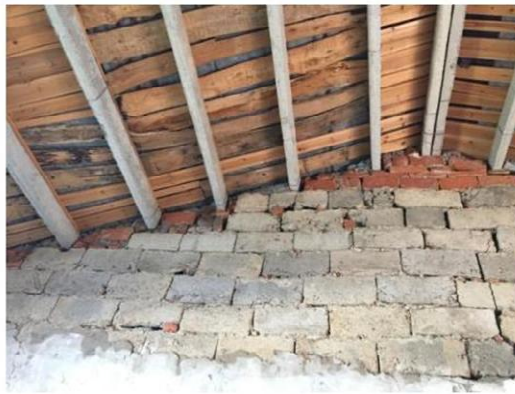
图 1.3- 22 砖或砌块墙承重，预制混凝土檩条、坡屋盖木屋面房屋
