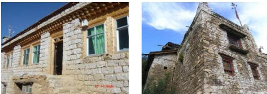
图 1.3- 24 石墙或石柱承重、木（楼）屋盖结构房屋
