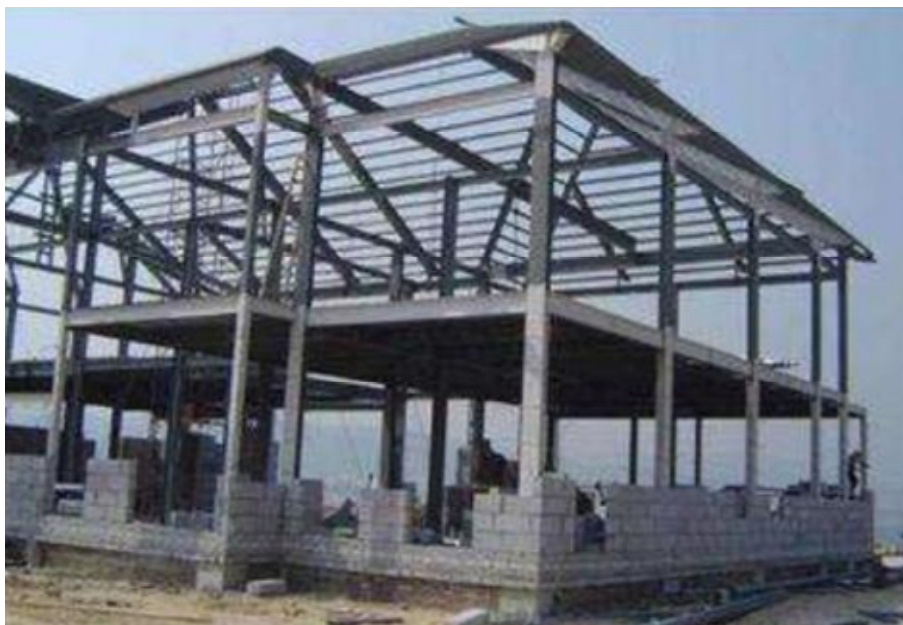
图 1.3- 11 钢和混凝土混杂结构
