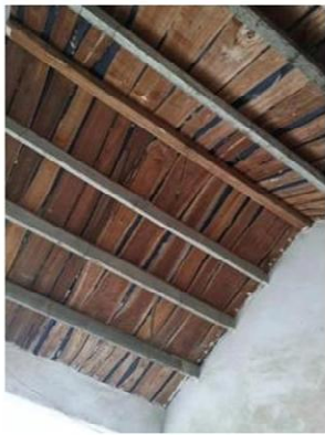
图 1.3- 22 砖或砌块墙承重，预制混凝土檩条、坡屋盖木屋面房屋
