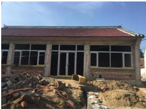
图 1.3- 23 采用轻钢屋架、木檩条的砌体结构房屋
