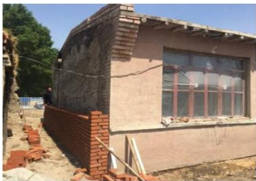
图 1.3- 45 前纵墙为砖墙，其余三面为生土墙的混杂结构房屋
