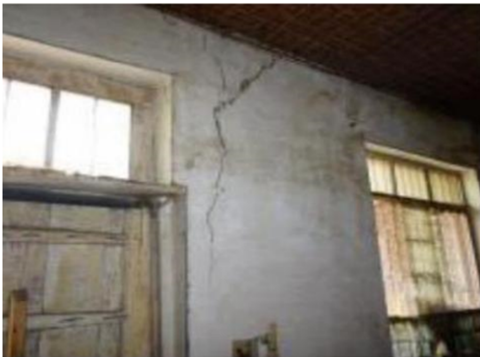
图 1.3- 64 墙体裂缝
