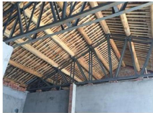
图 1.3- 23 采用轻钢屋架、木檩条的砌体结构房屋
