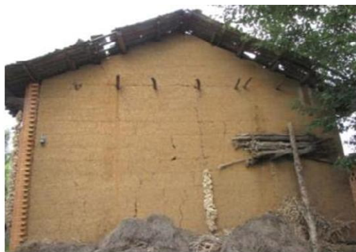
图 1.3- 45 前纵墙为砖墙，其余三面为生土墙的混杂结构房屋
