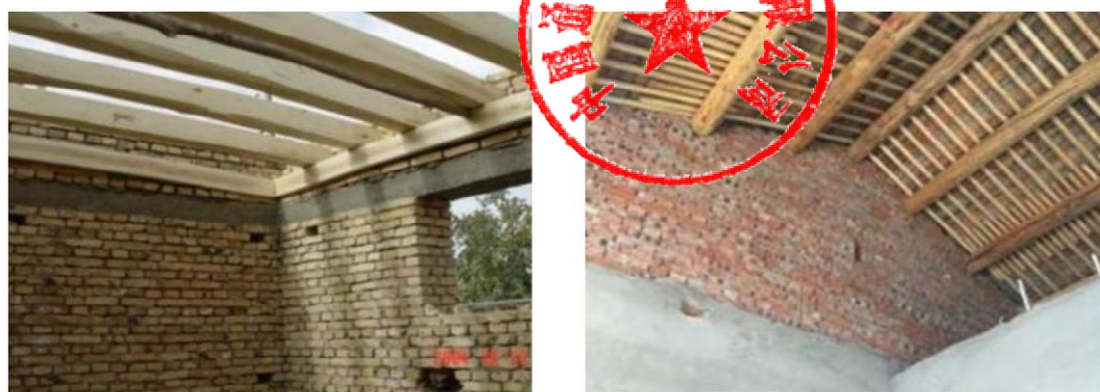
图 1.3- 21 新建砖木房屋，左为平屋盖，右为硬山搁檩坡屋盖
