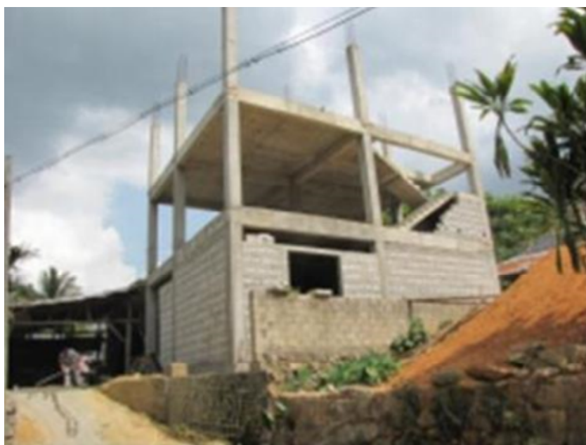
图 1.3- 55 在建的低层框架结构房屋
