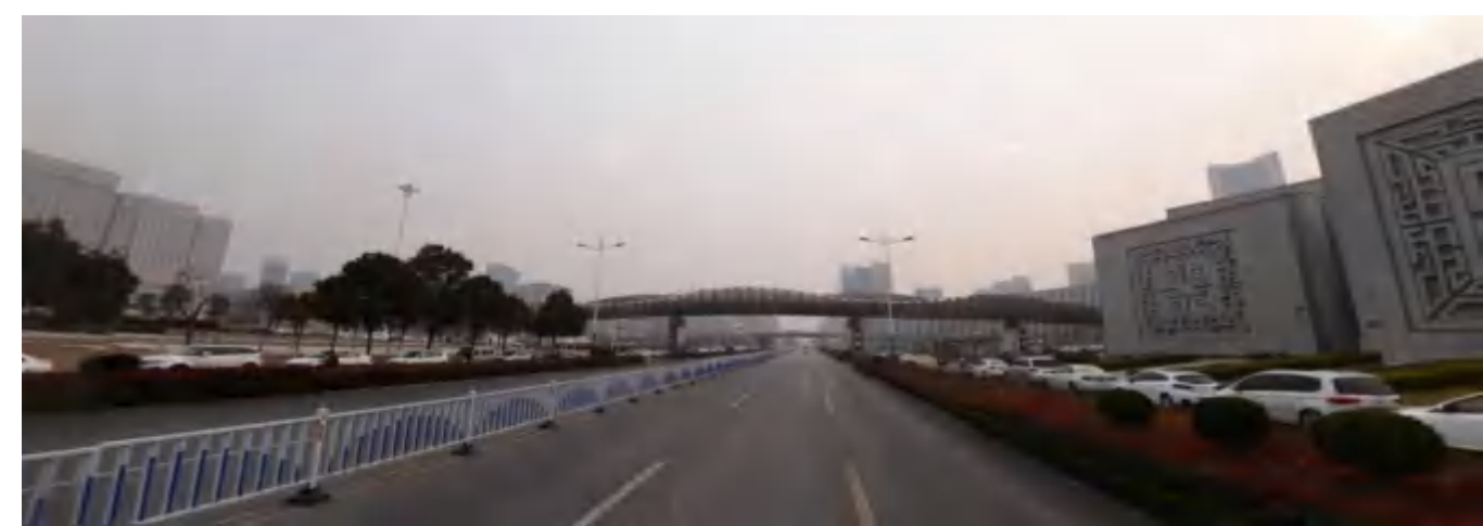
机非隔离带现状照片
