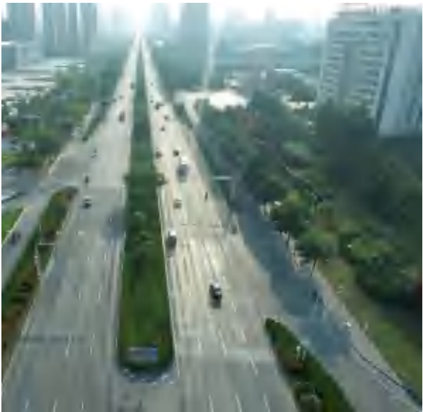
中央隔离带现状
