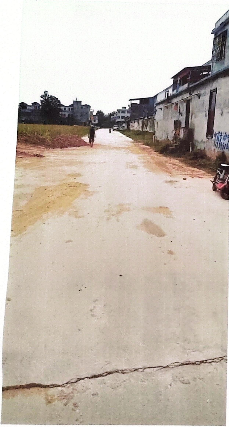
黑埠文化区道路施工后照片
