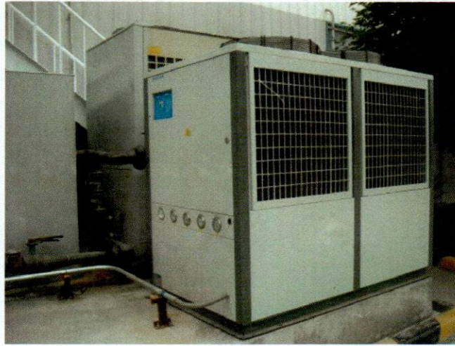
图 11. 冷水机组结构示意图
